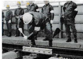
東海道・山陽新幹線のレール締結(1971年)
