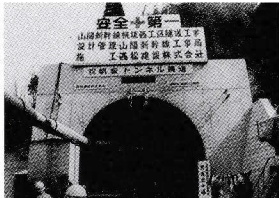
山陽新幹線帆板トンネル貫通式(1970年)
